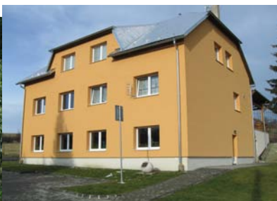
Oprava budovy Sahara
