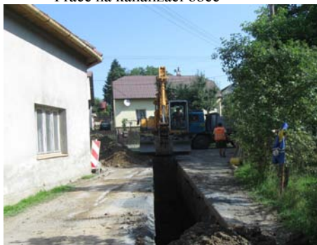
Práce na kanalizaci obce
