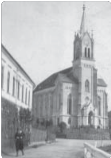
Ve třicátých letech 20. století vyfotil neznámý autor videčský kostel a po jeho levé straně část školní budovy.
