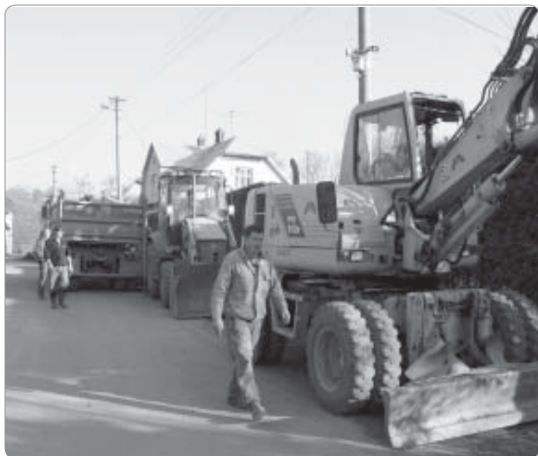
Výstavba kanalizace ve Vidči pokračuje podle schváleného harmonogramu.
