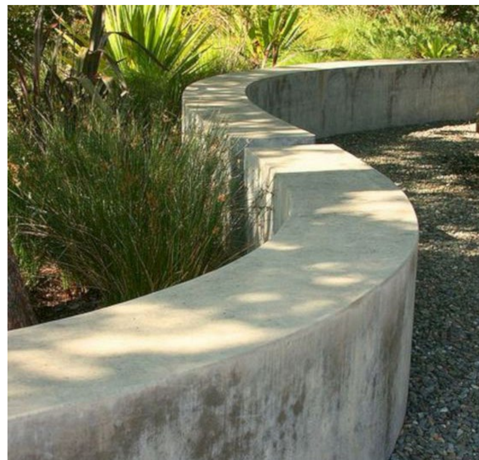
Zídka z hladkého pohledového betonu
