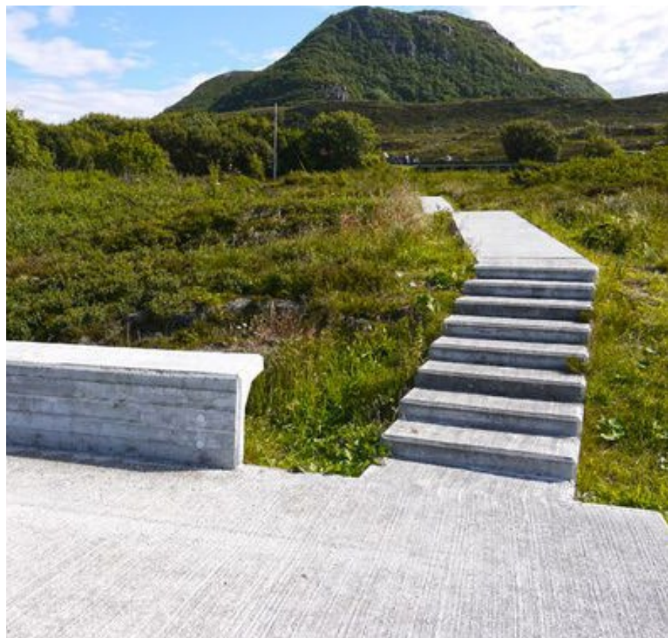
Kartáčovaný beton, schodiště
